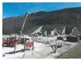
Das künftige Nordportal des Gotthard-Basistunnels. © AlpTransit Gotthard AG
