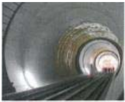
Haupttöhre im Bereich Multifunktionsstelle. © AlpTransit Gotthard AG
