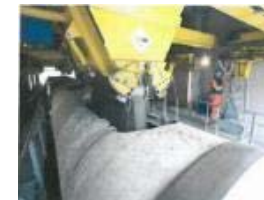
Boden: Beschicken eines Bauszugs mit Beton
