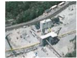
Der Installationsplatz bei Sigirio. © AlpTransit Gotthard AG
